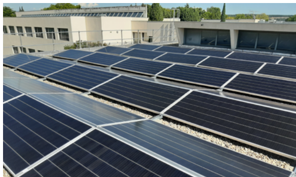
↑ Installation d'une centrale photovoltaïque sur le toit du CERI, financé par le plan France Relance.
